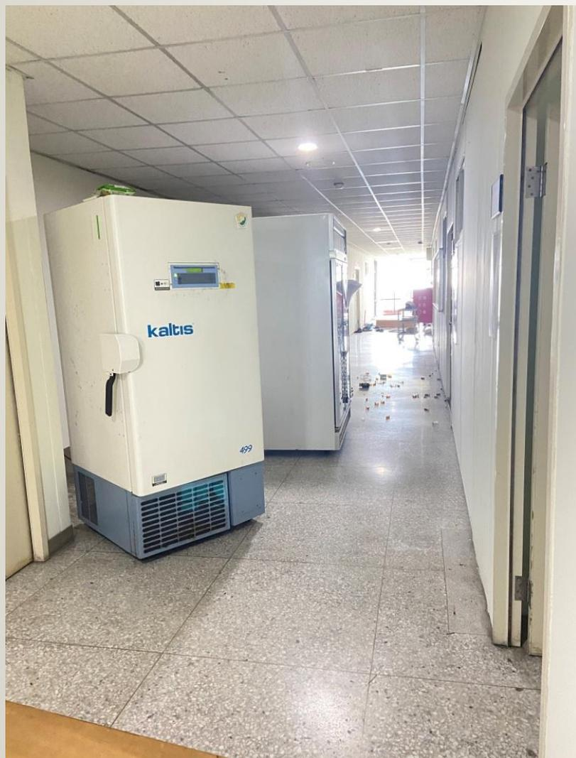
大型冷凍冷藏冰箱、植物培養箱位移
